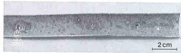
Bild 6. Vereinzelter Lochfraß in einem Kondensatorrohr ( \text{CuZn 20 Al} ) nach sechs Betriebsjahren.
