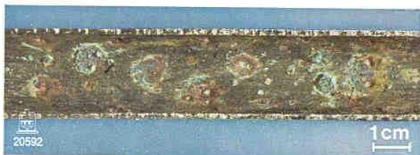
Bild 5. Zahlreicher Lochfraß in einem Nebenkühlerrohr ( \text{CuNi 10 Fe} ) nach den ersten Betriebsmonaten.
